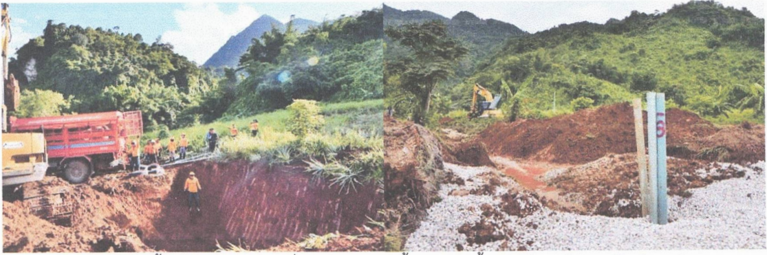
ธนาคารน้ำใต้ดินระบบบ่อปิด เพื่อช่วยลดปริมาณน้ำท่วมขังในถ้ำหลวงช่วยเหลือ 13 ชีวิตที่หมูป่า
