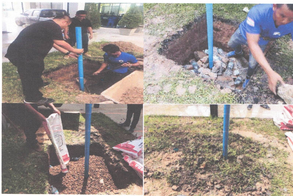
การทำธนาคารน้ำใต้ดินระบบบ่อปิดแบบบ่อชุด
