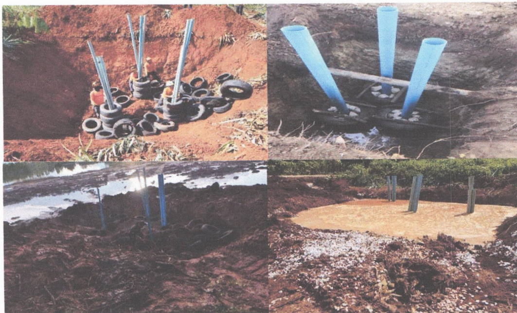
ลักษณะธนาคารน้ำใต้ดินระบบบ่อปิด ในพื้นที่น้ำท่วมขนาดใหญ่หรือน้ำท่วมทุ่ง
