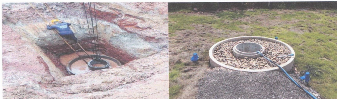
ลักษณะธนาคารน้ำใต้ดินระบบบ่อมหัศจรรย์ทูอินวัน แบบใส่ท่อ 2 วง
