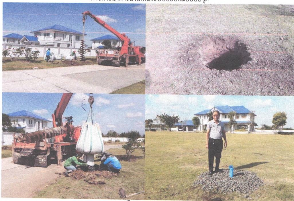
การทำธนาคารน้ำใต้ดินระบบบ่อปิดแบบบ่อเจาะ
