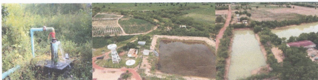
ประโยชน์จากธนาคารน้ำใต้ดินในการเพิ่มปริมาณน้ำจากบ่อบาดาล และสระน้ำเพื่อผลิตน้ำประปาชุมชน
